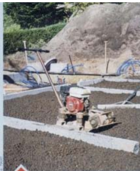
Podłoga na gruncie, ocieplona keramzytem
